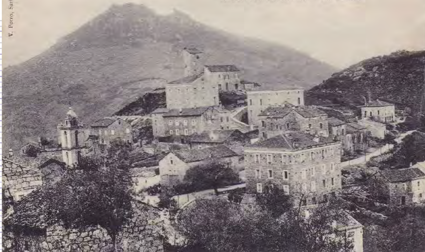
Arbellara (alt. 350 m.) — Vue Partielle
